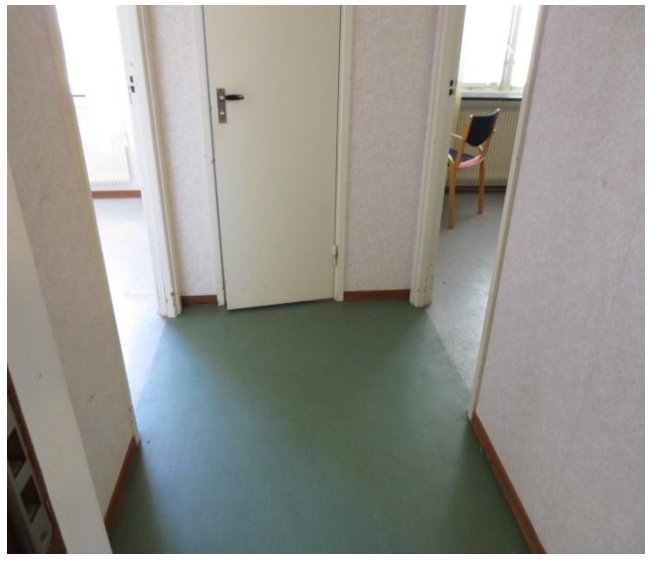
I boenderum ligger ofta grå matta. I hallar ligger samma slags matta i olika kulörer. Alla innehåller asbest. I några av boenderummen är mattan utbytt mot linoleum. Asbesthaltigt lim kan finnas under.
