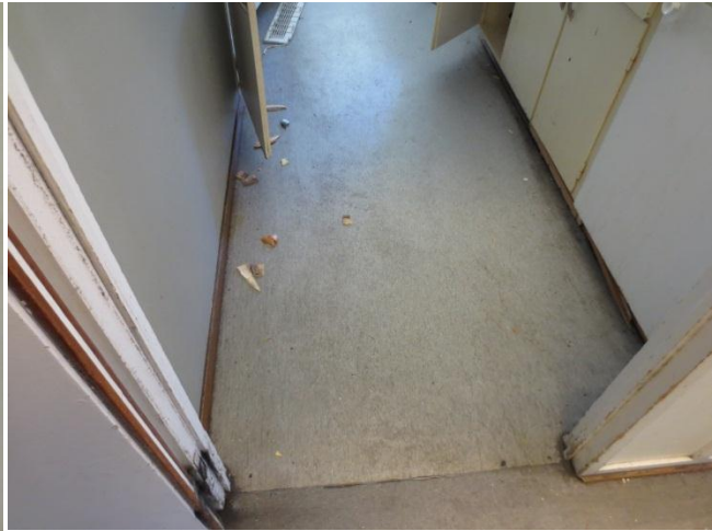
Grå matta i korridorer, samt ljusare grå matta i kaffekök, förråd m m innehåller asbest
