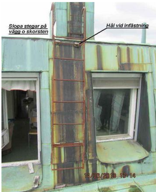
Takstegar rostiga, infästningar dåliga. Taktäckningen skadad vid infästningspunkter (bild ovan, nedan)
