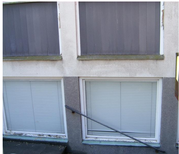
Bild 6: Sockel vid källarnedgång
