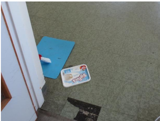
Gröna och blågröna vinylplastplattor o svartlim innehållande asbest finns på bl a vindsplan.
