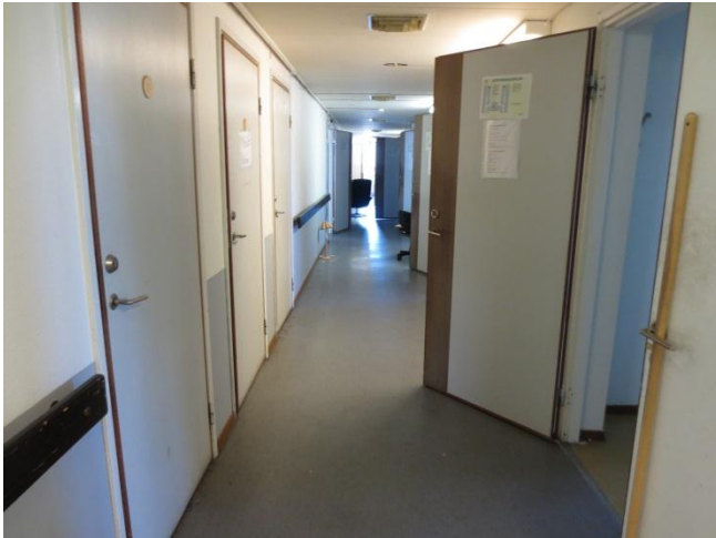
Grå matta i korridorer, samt ljusare grå matta i kaffekök, förråd m m innehåller asbest
