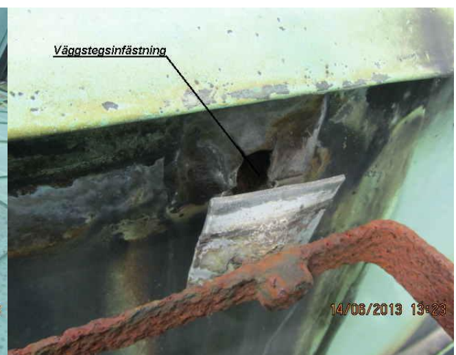
Takstegar rostiga, infästningar dåliga. Taktäckningen skadad vid infästningspunkter (bild ovan, nedan)
