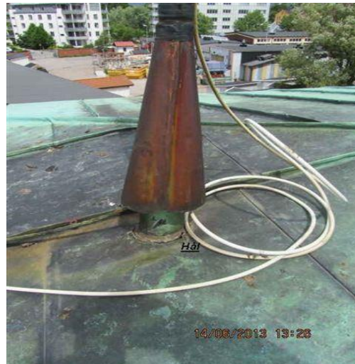
Skador vid infäst TV-antenn. Annan lösning för TV-mottagning rekommenderas.
