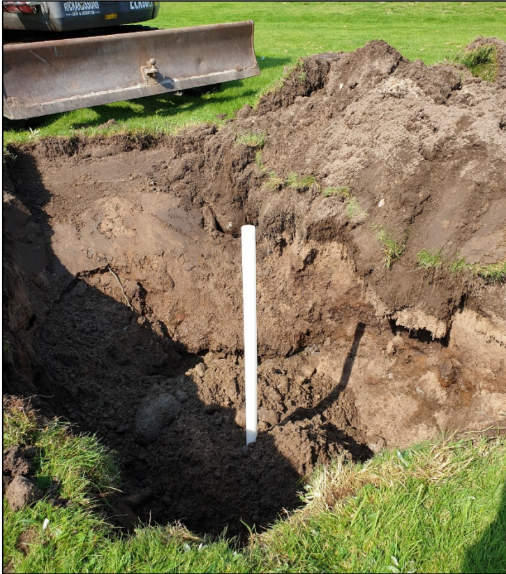
Figur 6. Installation av grundvattenrör i PG2 (GV2).
