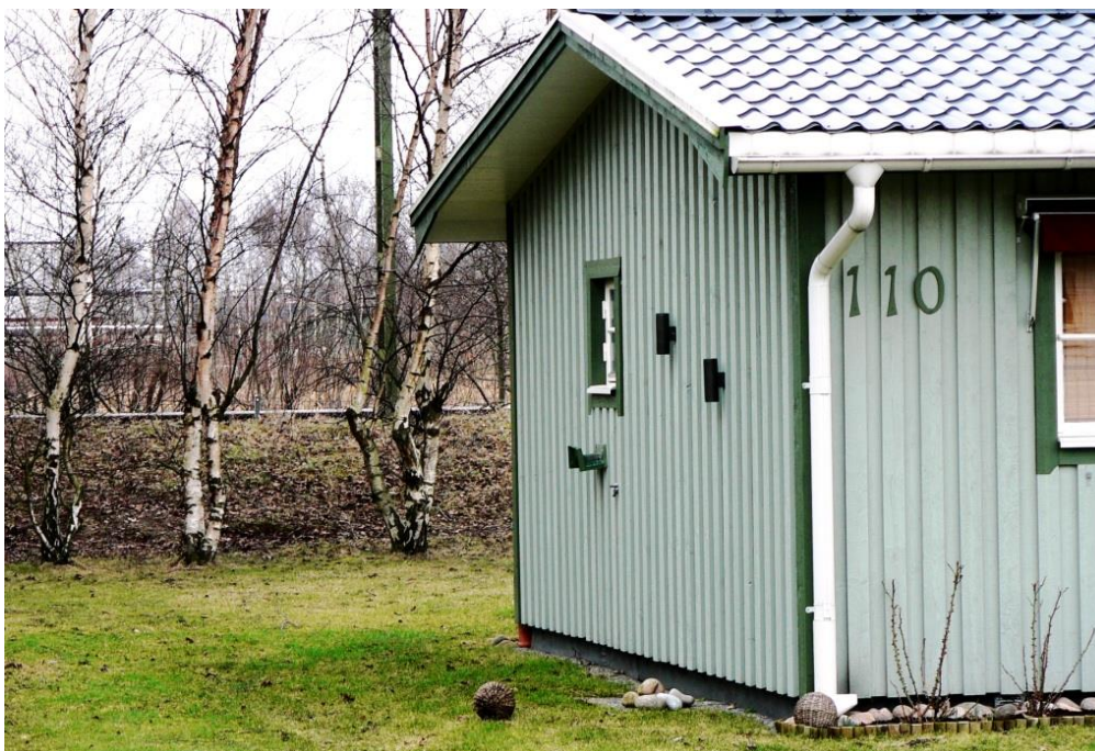
Figur 9. Hus intill järnvägen, Svanen, Östra Stranden.
