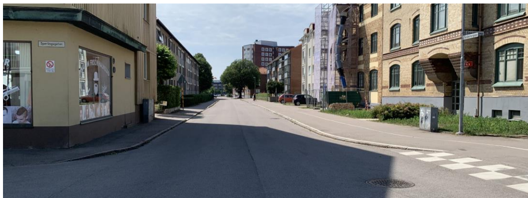
Figur 17 Snöstorpsvägen, sett i västlig riktning i höjd med Sperlingsgatan. Fredsgatan tar vid efter det höga huset i bakgrunden. AFRY, 2022.
