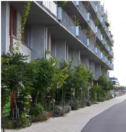
Figur 11 Ojämn fasad i kombination med vegetation, "Ohboy", Malmö
