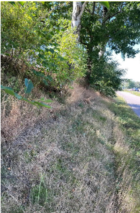
Figur 4: Slänt ner mot gång- och cykelväg norr om fastigheten
