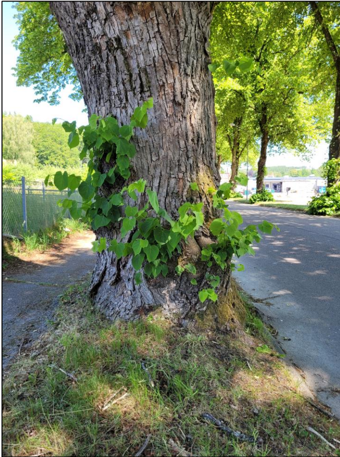
Figur 6. Träd med ID nr 4 står på en gräsyta med ungefär 1 m bredd mellan gångväg och bilväg där asfalten tydligt buktar upp på grund av rötterna.
