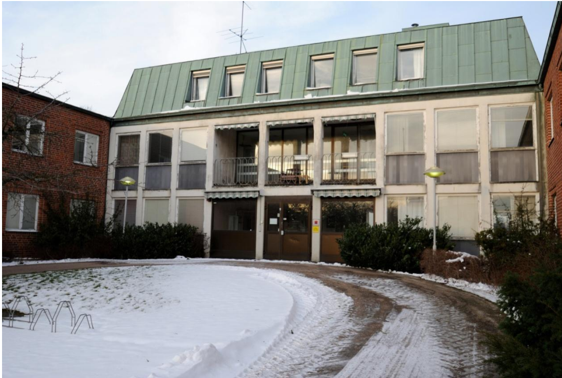
Huvudbyggnaden. Entrépartiet har tidigare varit indraget liksom andra våningen.
