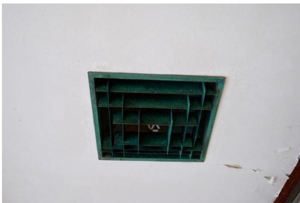
Takarmatur i kopparplåt.
