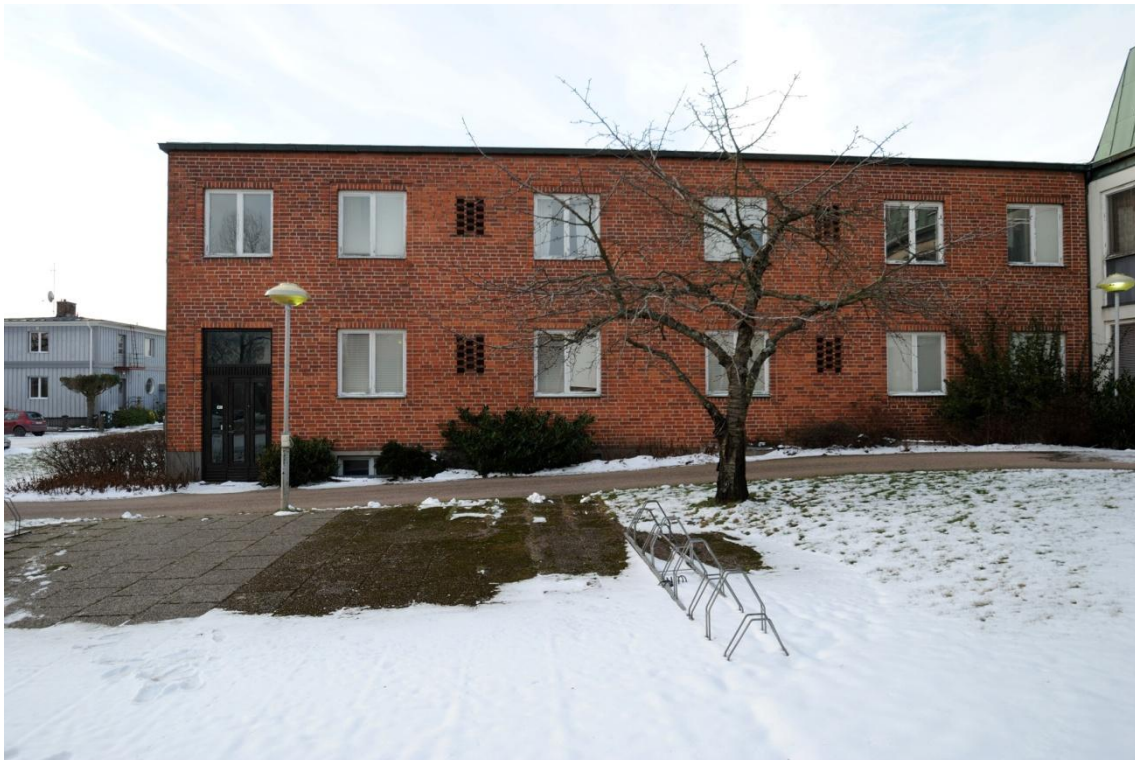
Innergården mot västra flygeln.
