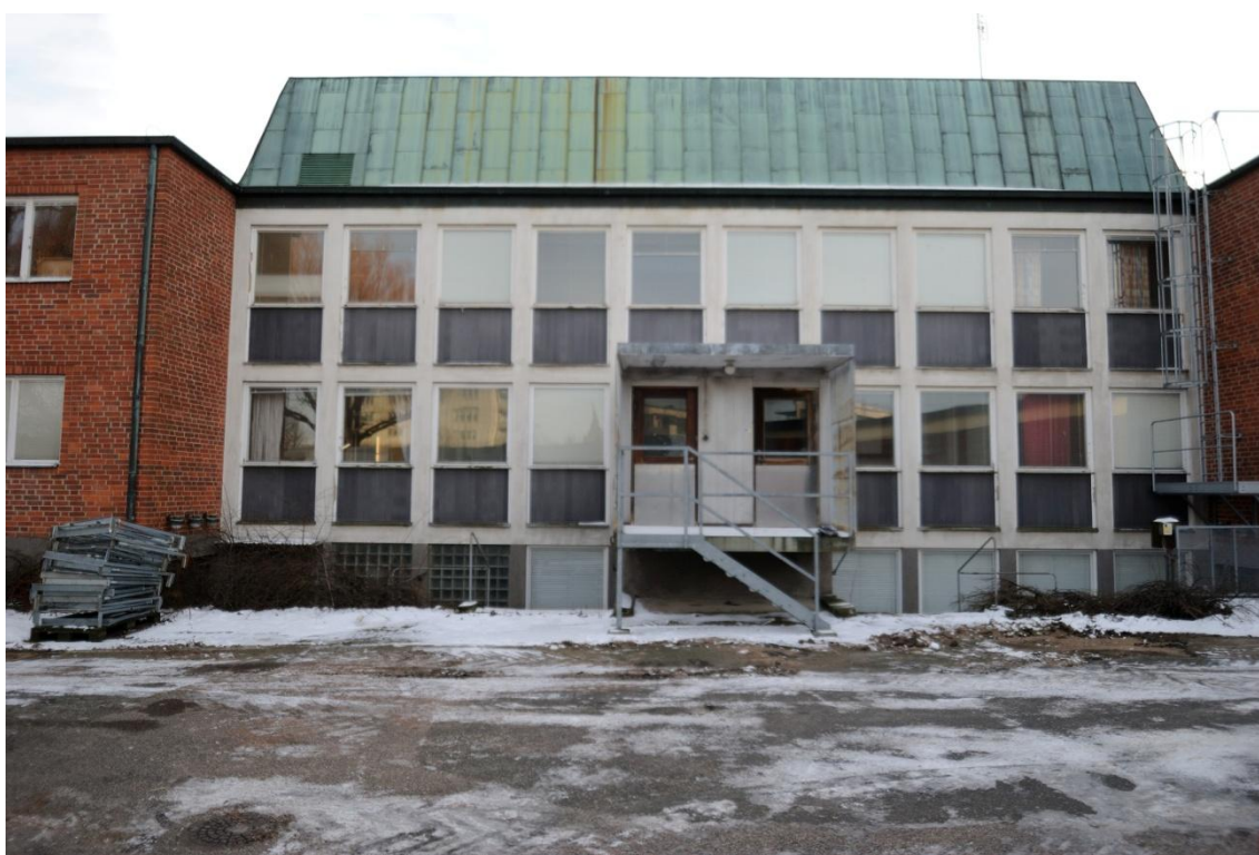
Centralbyggnaden mot norr med varuintag och ingång till källarvåning.
