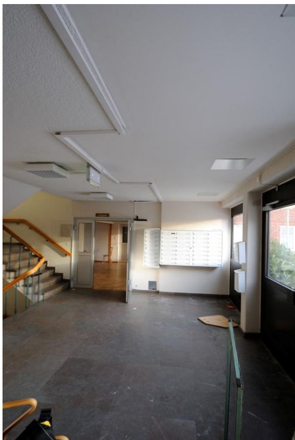
Vestibulen. I taket syns spår eftertidigare entréparti. Kalkstensgolv.
