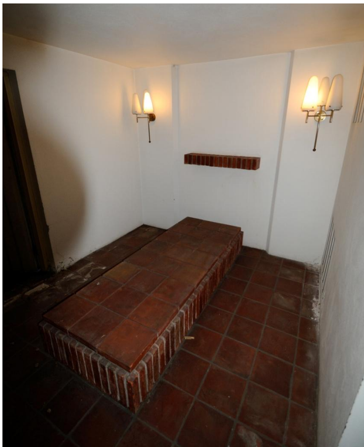
Svepningsrummet i källaren.
