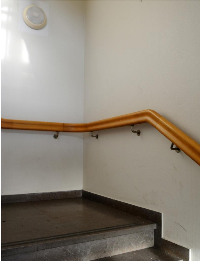
Detalj av trapphus med specialutformad handledare i björk.
