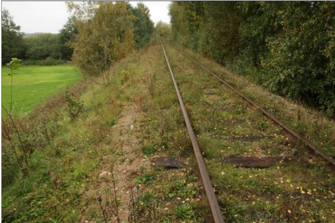
Fig. 8 Industrijärnvägen i norr har naturvärden som lätt kan förstärkas
