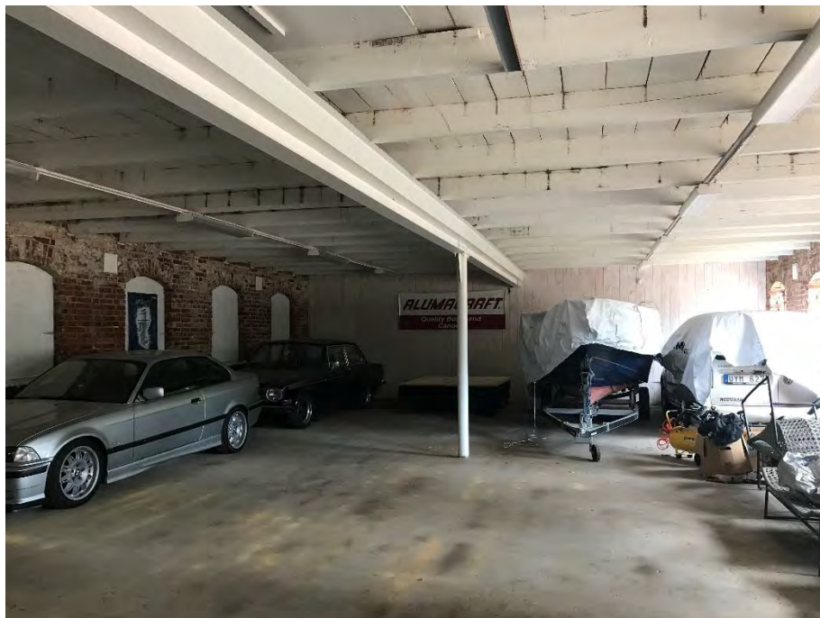
Figur 40. Ekonomilängan invändigt. Ny bäring med pelare och balk i stål.
