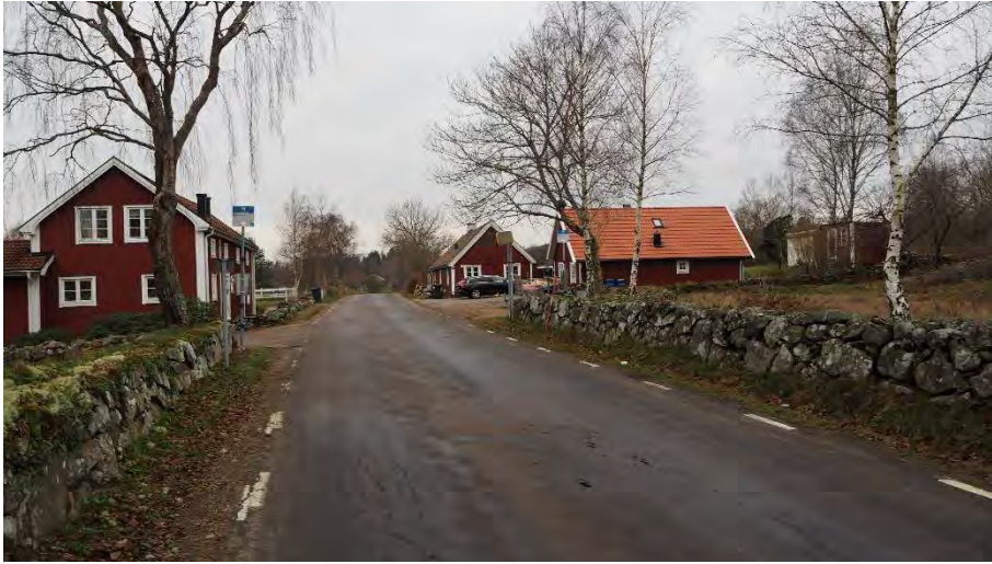
Figur 25. F.d. lanthandeln t.v. och gård t.h. Båda bostadshusen ligger med långsidan mot vägen och är omgärdade av gärdesgård av gråsten. Fasaderna är panelklädda och rödmålade. Sadeltaken täckta med lertegel.
