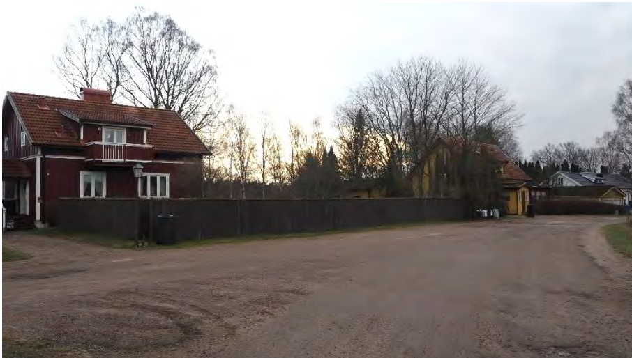
Figur 26. Egnahemsvillor utmed Bruksvägen. Även här är fasaderna i träpanel målade i kulörerna rött och vitt under sadeltak täckt med lertegelpannor.
