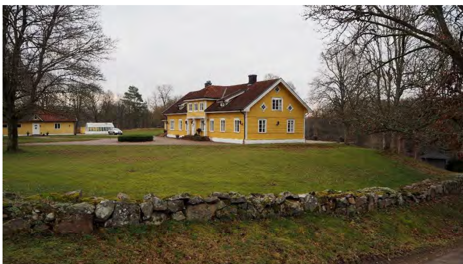
Figur 23. Den herrgårdsliknande disponentvillan är omgärdad av stengärdesgård och äldre träd. Den har markerad frontespis samt liggande och stående träpanel med kontursågade omfattningar under sadeltak.
