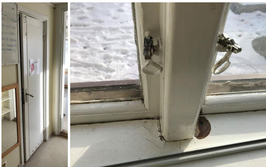
Figur 23. Äldre dörr som moderniserats vid ombyggnaden 1947 och fönstersnickerier från samma tillfälle.
