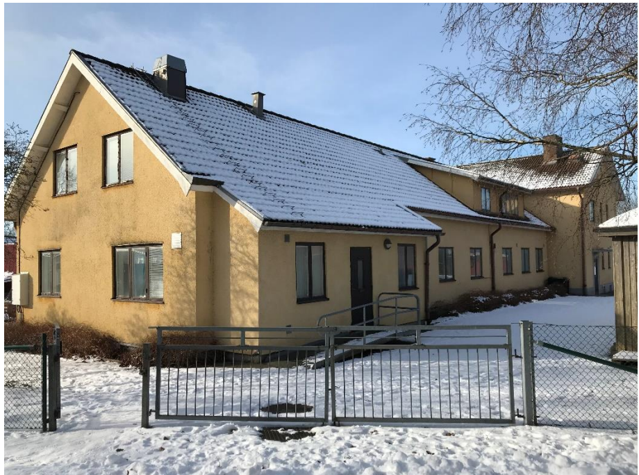
Figur 21. Det f.d. ålderdomshemmets fasad mot norr, notera den lilla tillbyggnaden kring entrén som till höger om denna innehåller källarnedgång från 1930 och till vänster skaffereri från 1947.
