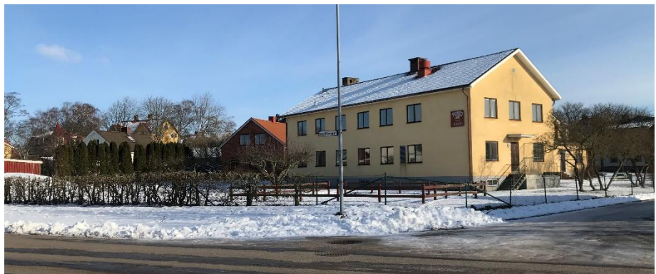
Figur 20. Det f.d. ålderdomshemmets fasad mot väster.
