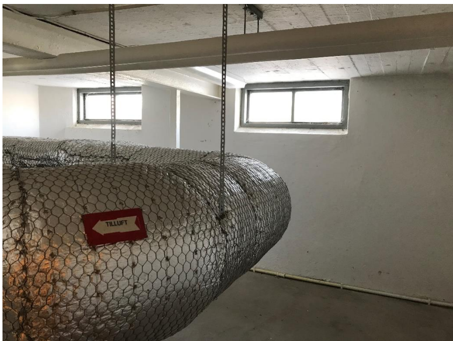
Figur 26. I källaren i tillbyggnaden syns spår av brädformen i taket.
