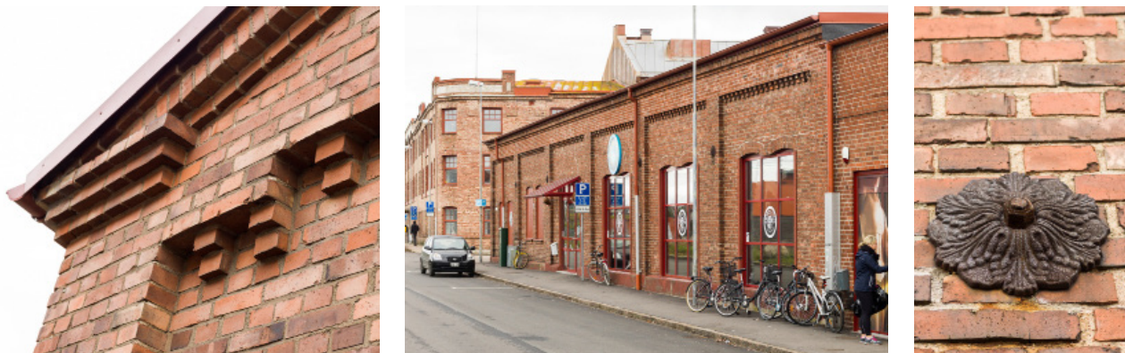
Bild 12: Befintlig snickeriverkstad med fasad och byggnadsdetaljer.
