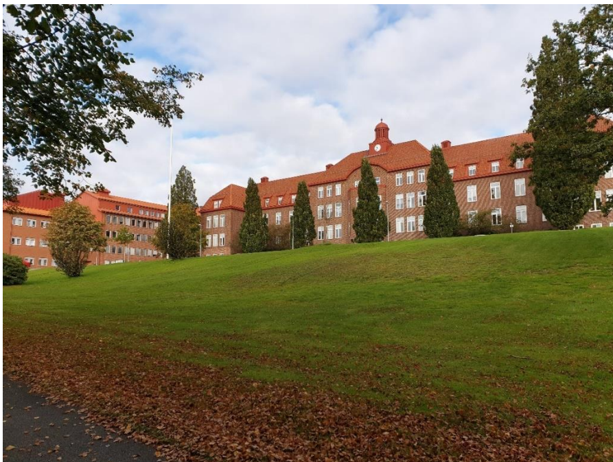
Figur 23 Vy över sjukhusparken och den gamla huvudbyggnaden. Foto Ramböll, oktober 2019.
