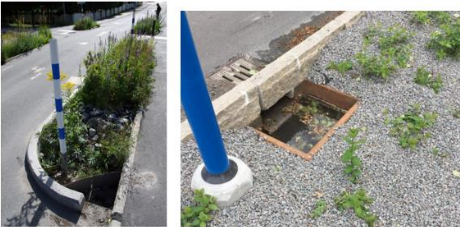
Figur 15 Olika inloppstyper. Inloppet rekommenderas utformas med ett sandfång och/eller erosionsskydd (Stockholm vatten och avfall, WRS, 2023).
