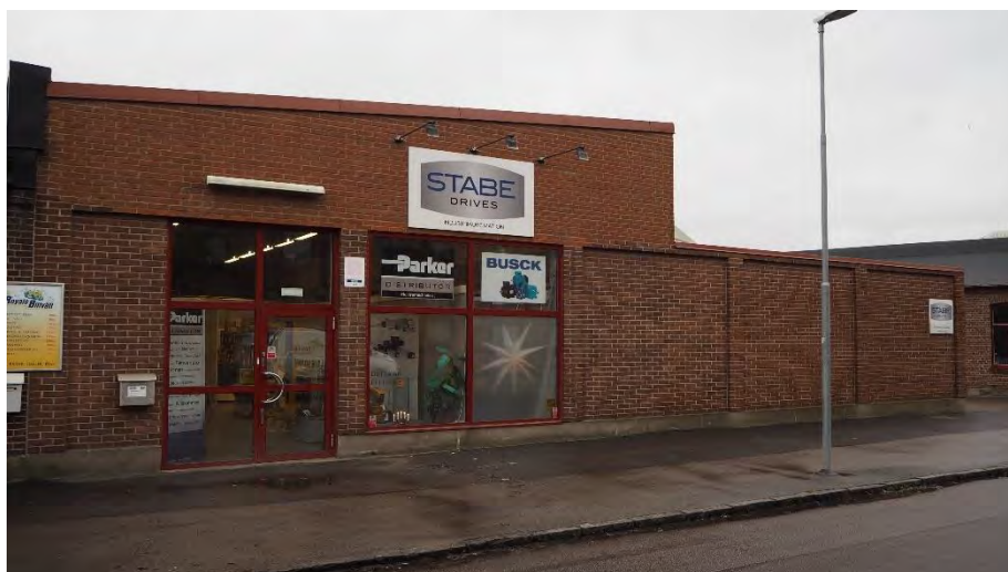
Figur 31 STABE i fastighetens norra del, uppförd 1980 och ombyggd 2001, notera lisenerna i muren, foto från Sperlingsgatan.
