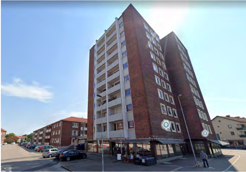
Figur 10. På södra sidan av Muraregatan i kvarteret Kammaren finns bostadshus i tre våningar och ett punkthus i tio våningar.
