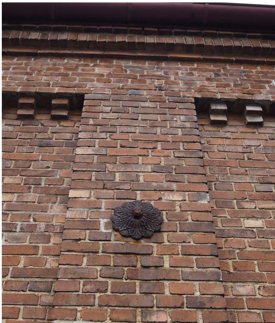
Figur 27 Detalj av den f.d. snickeriverkstadens fasad mot Nässjögatan med mönstermurning och ornamenterad ankarplatta.
