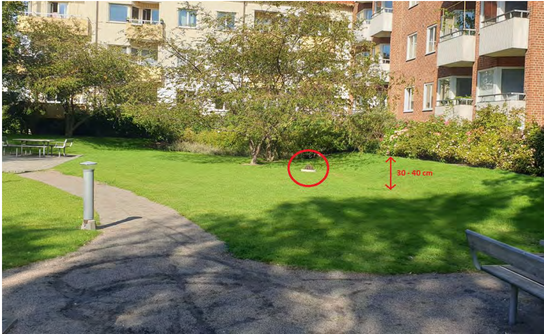
Figur 22 Illustration över överdämningsyta / torrdamm i Augustenborg, Malmö. En gräsmatta och lekplats fungerar som temporär överdämningsyta för dagvatten och skyfall. Små mängder vatten infiltrerar och när vattennivån stiger rinner vatten ut genom en upphöjd kupolbrunn
