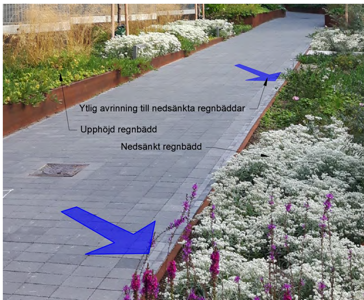
Figur 21 Illustration över en kombination av upphöjda respektive nedsänkta regnbäddar med ytlig avrinning från hårdgjord mark till nedsänkta grönytor
