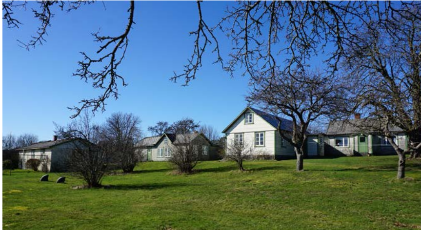
Översiktlig bild över byggnaderna på fastigheten.
