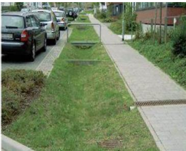
Figur 19 Exempel på svackdike. Takvatten avleds mot svackdike.
