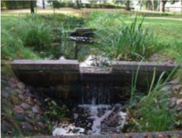
Figur 18 Svackdike med dämman. Foto: Veg Tech.
