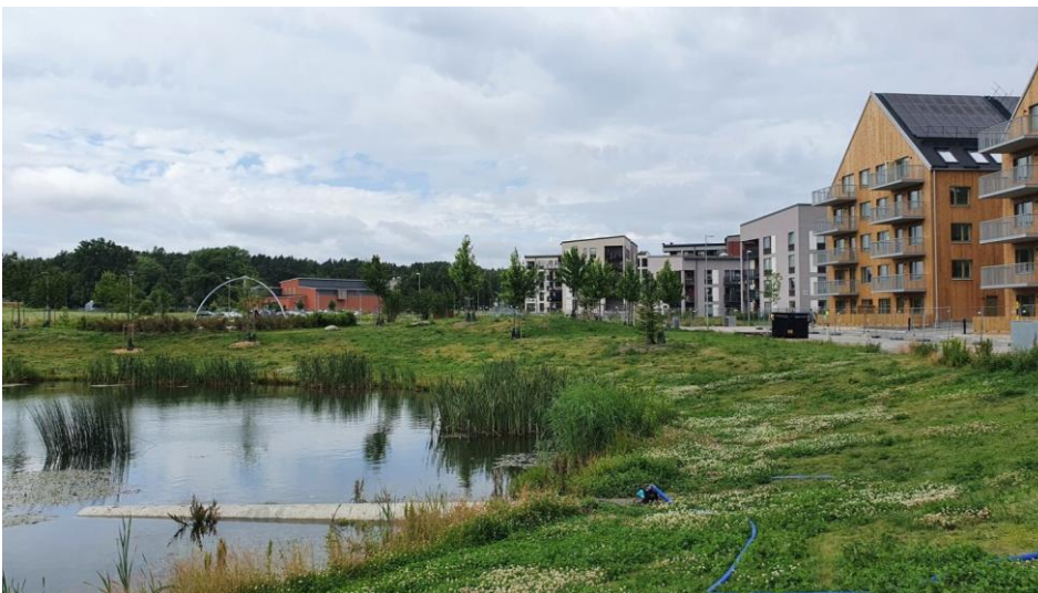
Figur 21 Våt dagvattendamm, Ultuna, Uppsala. Källa: Sweco, 2021.
