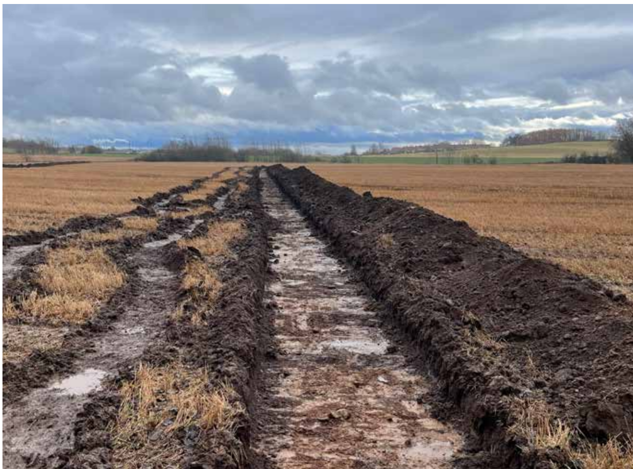
Figur 4. Den leriga och mycket blöta marken inom Prästjordens VV försvårade schaktningsarbetet och igenläggningen. Mot sydost. (Fotonr. 2024-1-9). Foto: Linda Wigert.
