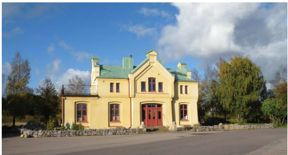
F d stationsbyggnaden i Getinge, bild tagen från öster (5)
