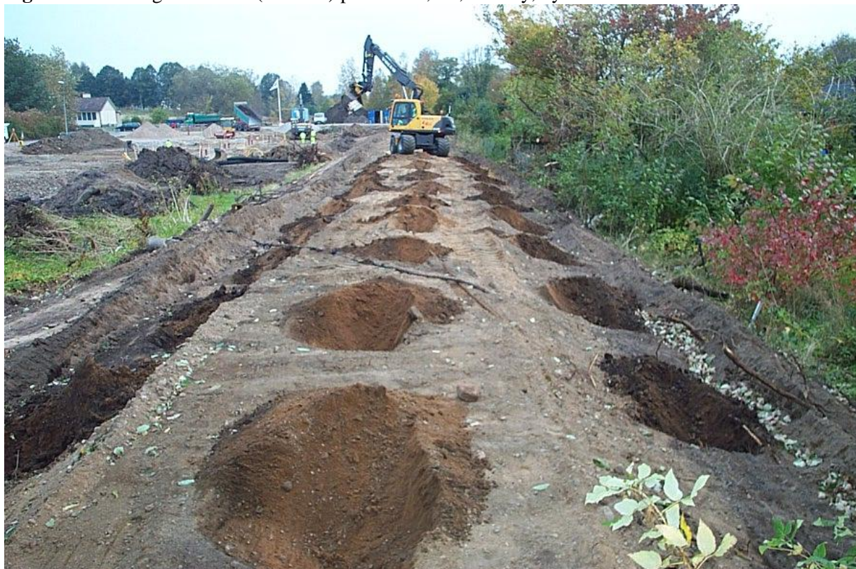
Figur 6. Saneringsområde E (närmast) och D på nivån 0,5-0,8 mummy (schaktbotten), vy mot norr.
