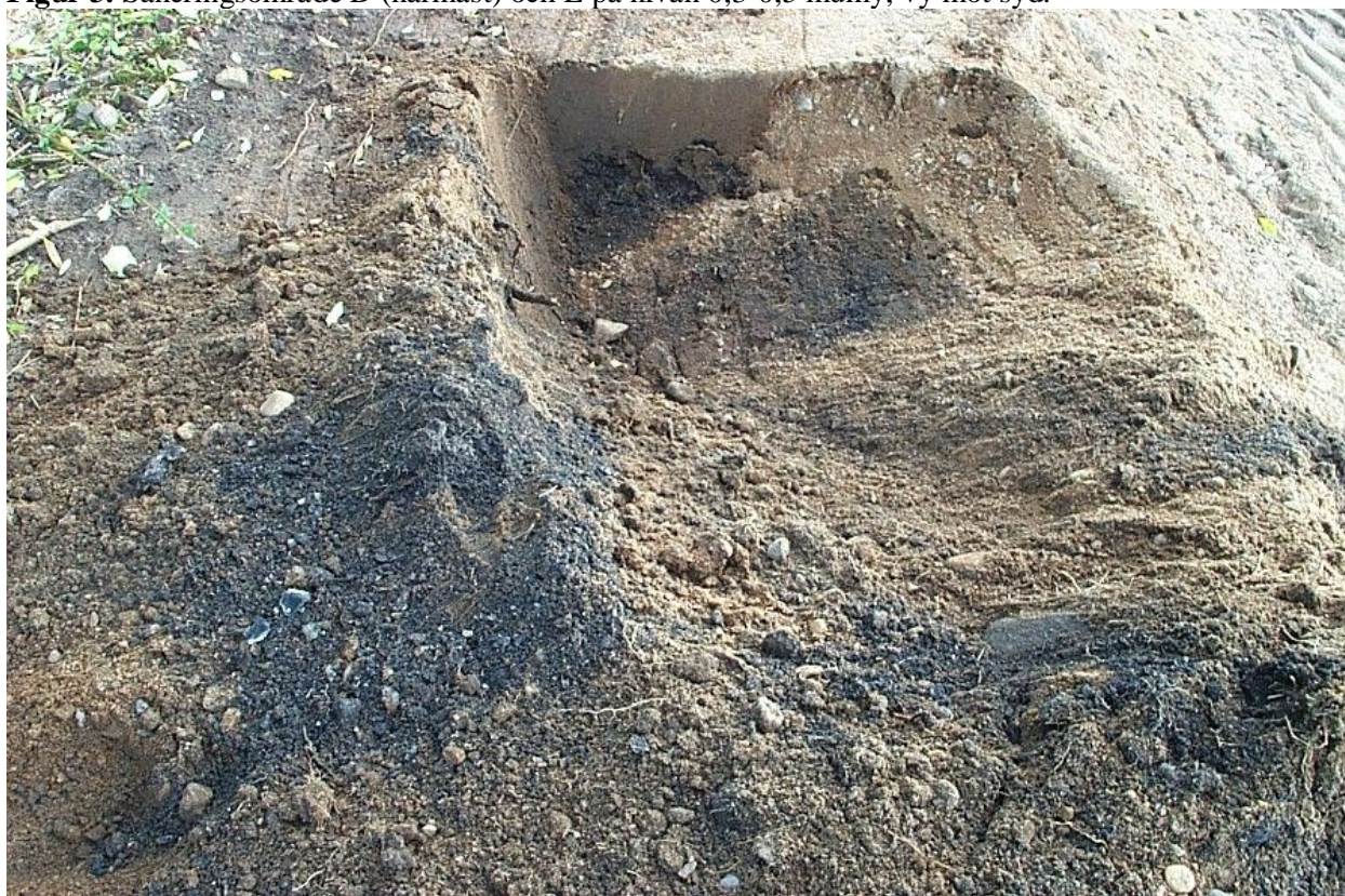
Figur 4. Aska fanns utmed större delen av järnvägssträckan, här i saneringsområde D på nivån 0,3-0,5 mummy. All synlig aska togs bort.
