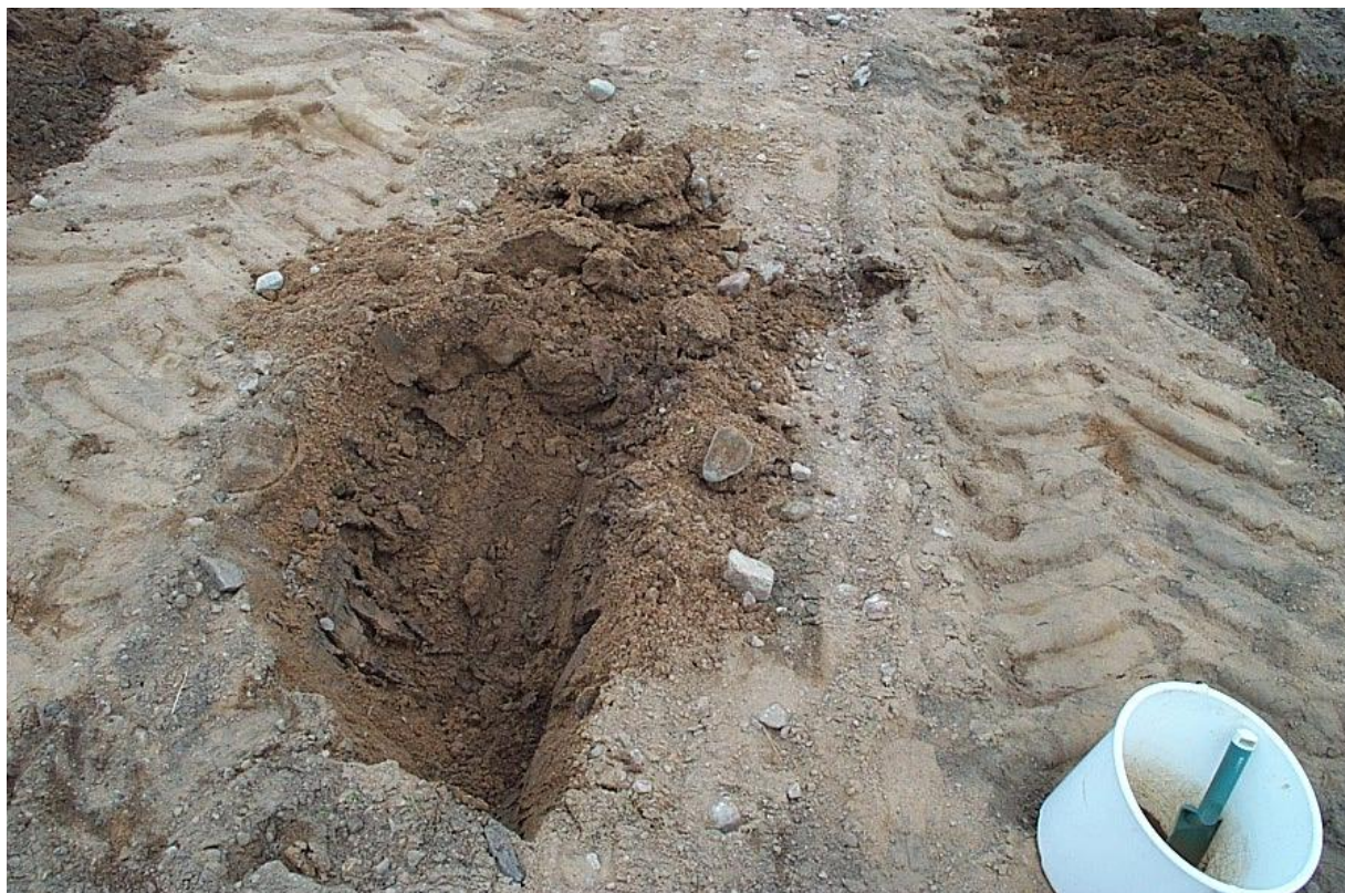
Figur 7. Saneringsområde C, ett av "jacken" på nivån 0,5-0,8 mummy (schaktbotten).
