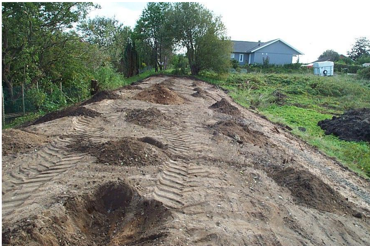
Figur 3. Saneringsområde D (närmast) och E på nivån 0,3-0,5 mummy, vy mot syd.
