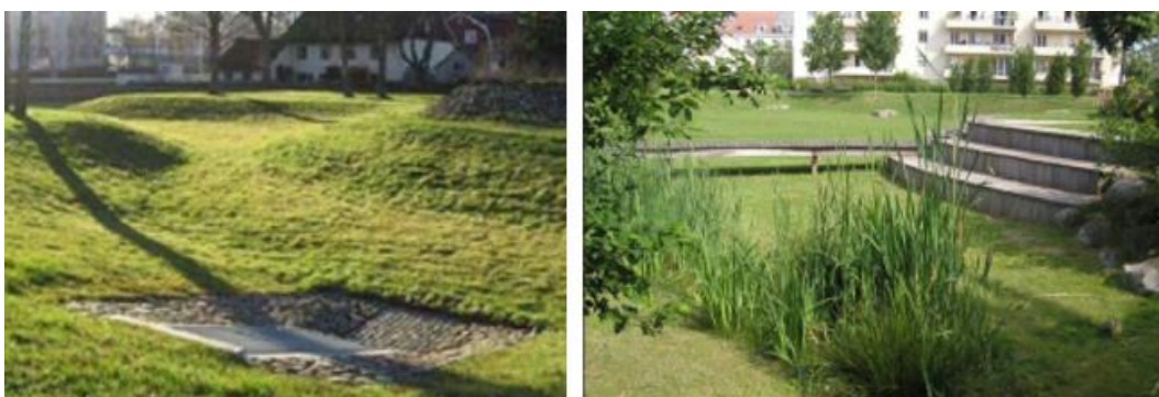
Figur 14. Exempel på gräsbeklädda torra fördröjningsmagasin som används som lekplats under torrväder och/eller har integrerats i gestaltningen av området. Källa: Svenskt Vatten, Rapport Nr 2019-20.
