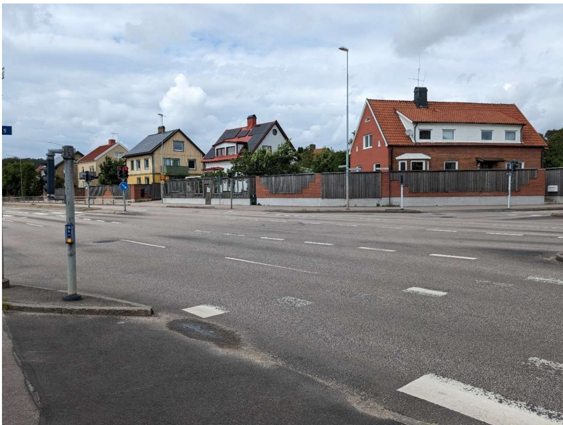
Figur 10. Bullerskydd i korsningen Wrangelsgatan/Furuvägen
