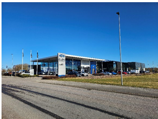
Befintlig byggnation vid Kundvägen
