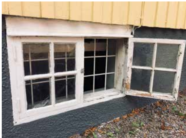
Byggnadens fönster är utåtgående träfönster med fast spröjs och mittpost.
