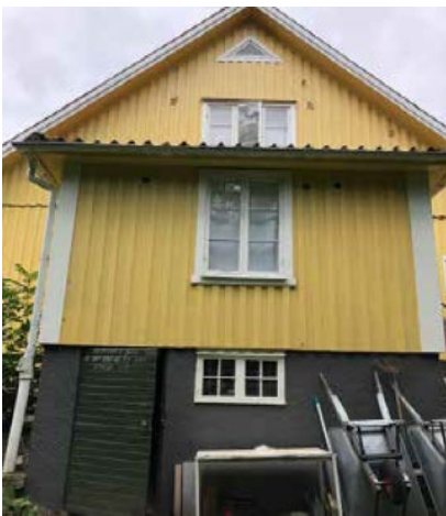
Byggnadens fönster är utåtgående träfönster med fast spröjs och mittpost.
