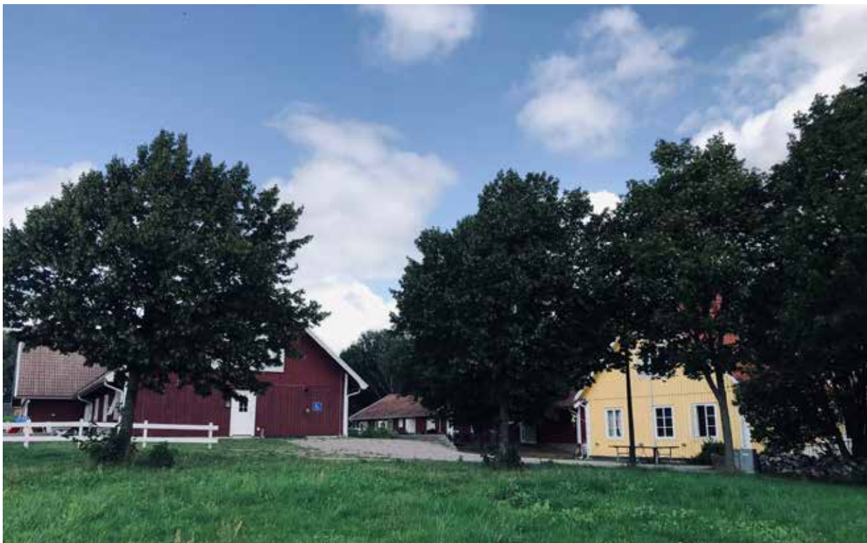
Den nya bebyggelsen norr om huvudbyggnaden an knyter delvis till de rivna ekonomibyggnaderna.
