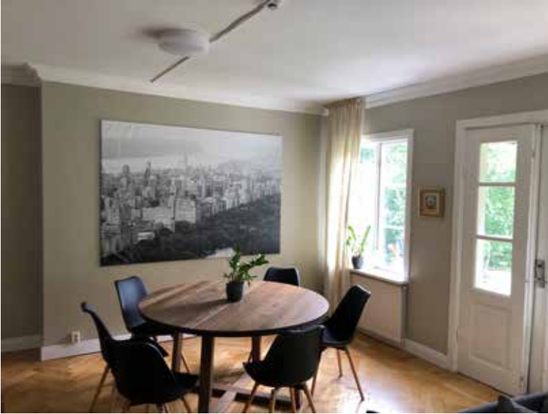
Rummet vid entrén, Matrummet. Nya profilerade lister (av frigolit) har monterats av nuvarande ägare. Dessa var dessförinnan släta efter tidigare renovering.
