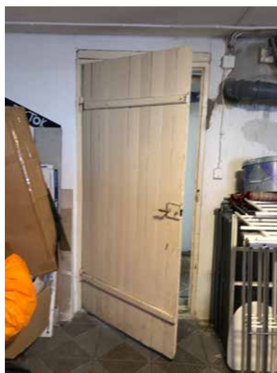
Enkel brädörr med kammarlås i källaren.
