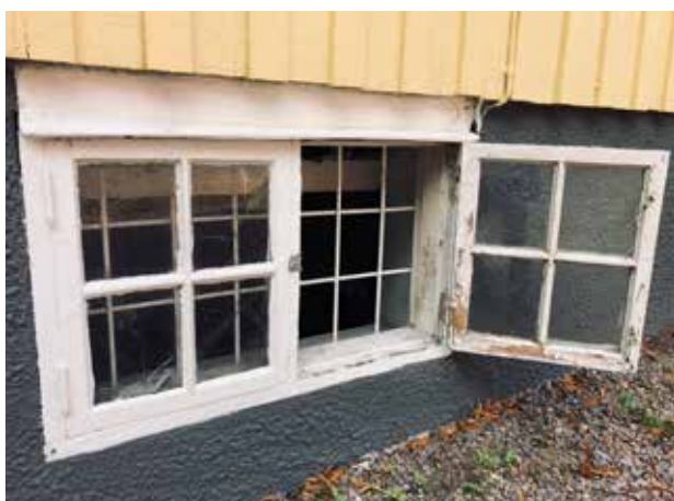
Ursprungligt källarfönster från 1925.
