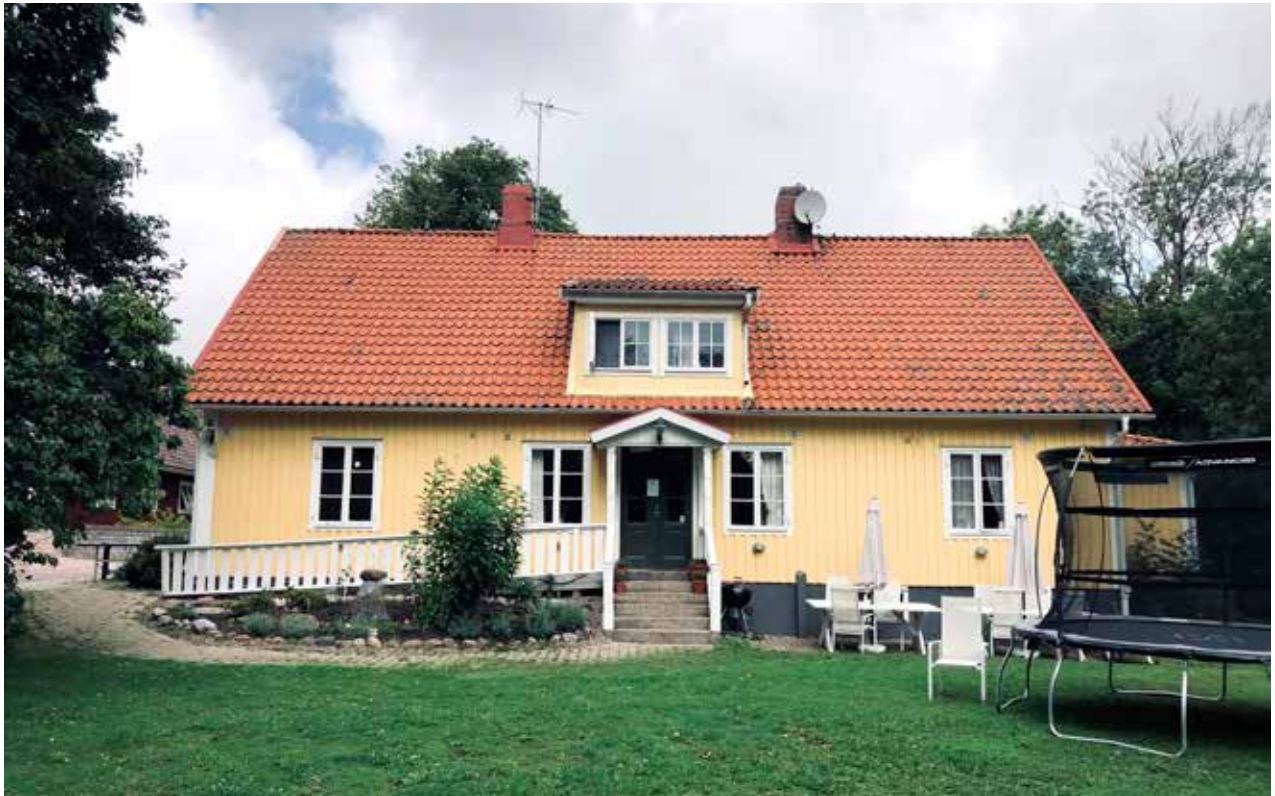
Södra fasaden. Rampen till vänster om entrén har tillkommit under 2000-talet.
