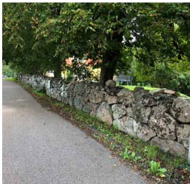
Den gamla muren utmed uppfarten.
