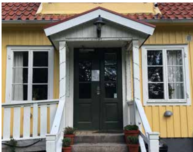
Entrépartiet med förstuvist mot söder. Notera gångjärnen till de borttagna fönsterluckorna.
