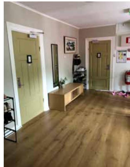
Övre hallen. Spegeldörrarna och dörrfodren är från byggåtervinning och har monterats av nuvarande ägare. Dessa var tidigare släta.
