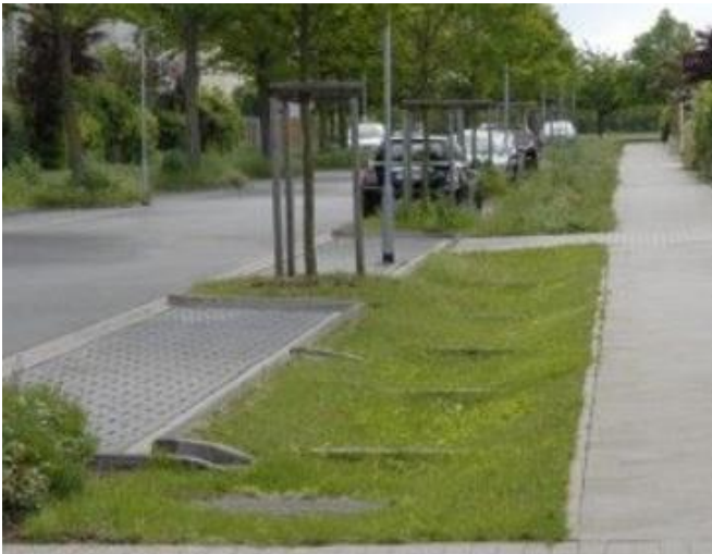
Figur 17 Exempel på svackdike med dämmen. Dagvatten från gata avleds mot svackdike.
