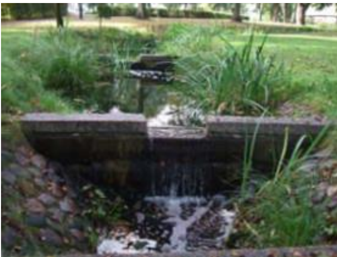
Figur 18 Svackdike med dämmen. Foto: Veg Tech.
