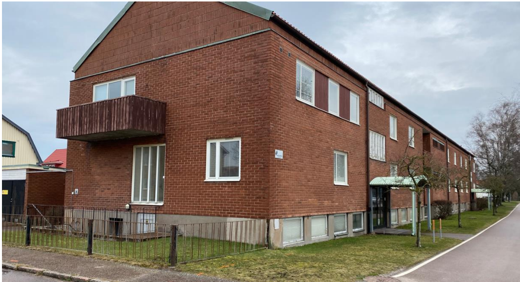
Figur 7-2. Södra och västra sidan. Riktning mot norr.
